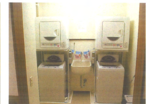
洗濯場(各階設置)
